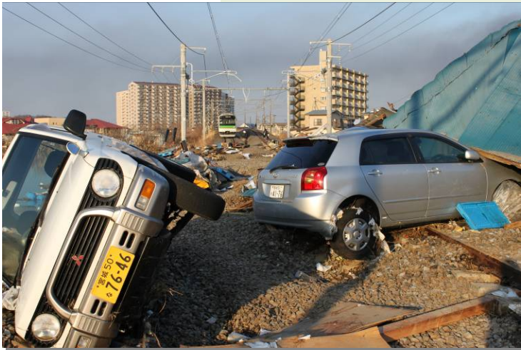
仙石線に乗り上げた車(写真提供藤原益栄多賀城市議)
