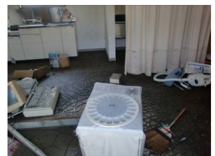
ヘドロが残る内部
