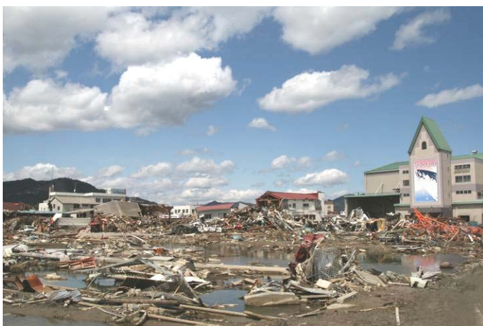
まだ水が引かない気仙沼市中心部
