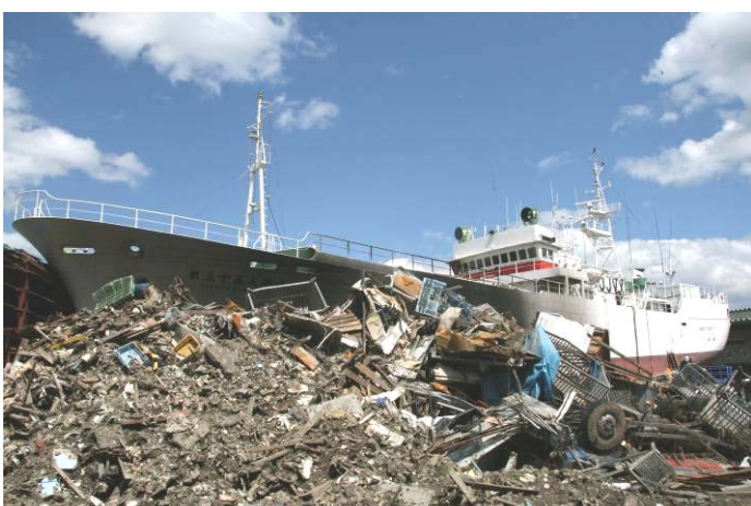
大型船が工場敷地内に打ち上げられていた (気仙沼市)
