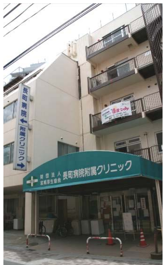
外観では被害の状況はわからない
