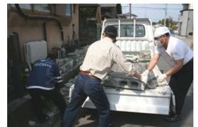
崩れたブロック塀を軽トラで運び出し
