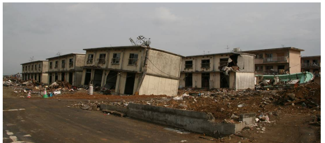
アパートの2階を超えて津波が押し寄せた
