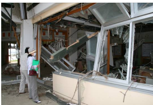
津波で壊れた野蒜保育所
